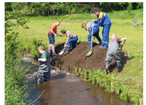
Jugendfeuerwehr Moissburg im Einsatz am Staersbach
