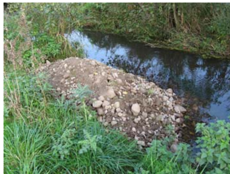
Kiesschüttung als Seiteneinengung im Staersbach
