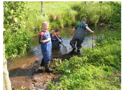
Beim Einbringen von Kies in das Gewässerbett
