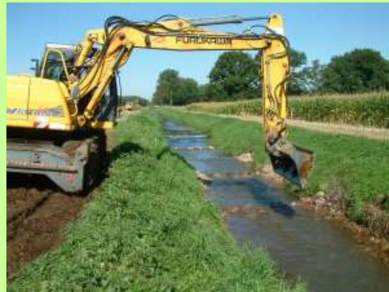
Umgestaltung eines Sohlabsturzes als Ausgleichsmaßnahme
